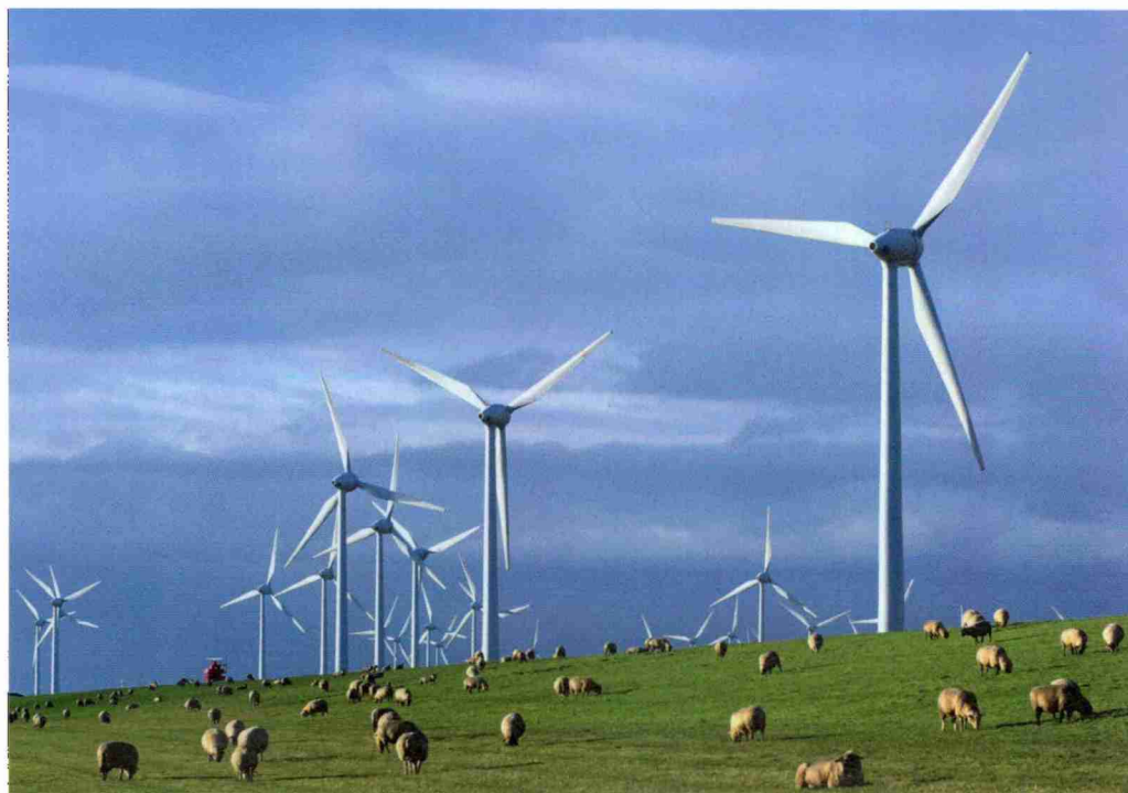
«Enorme Herausforderung für Hersteller und Betreiber»: Windpark in Deutschland.
