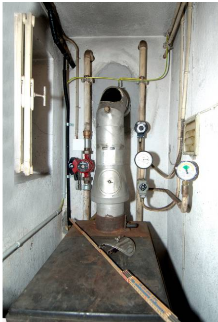
Légende: Voici l'encombrement dans la chaufferie, une transformation n'est effectivement guère possible : à chaque fois 10 cm latéralement, env. 50 cm devant le brûleur. La chaufferie convient parfaitement pour la propriétaire pour y sécher ses champignons dans une température ambiante élevée.
