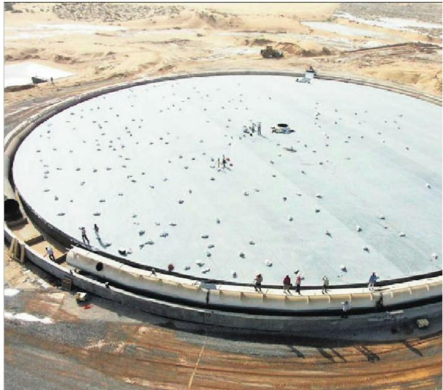
LE PROTOTYPE En construction dans le désert, une «île» de 80 mètres de diamètre repose sur un canal artificiel. Son rôle est de prouver la faisabilité et la pertinence du concept.
