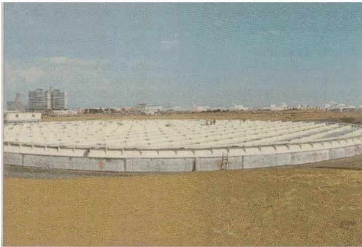
Île solaire de 80 mètres de diamètre, en cours de construction dans le désert de Ras-Al-Khaimah aux Emirats arabes unis. ARCHIVES
