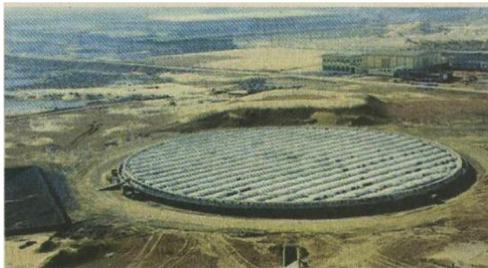
Île solaire de 80 m de diamètre, en cours de construction dans le désert de Ras-Al-Khaimah aux Emirats arabes unis.
