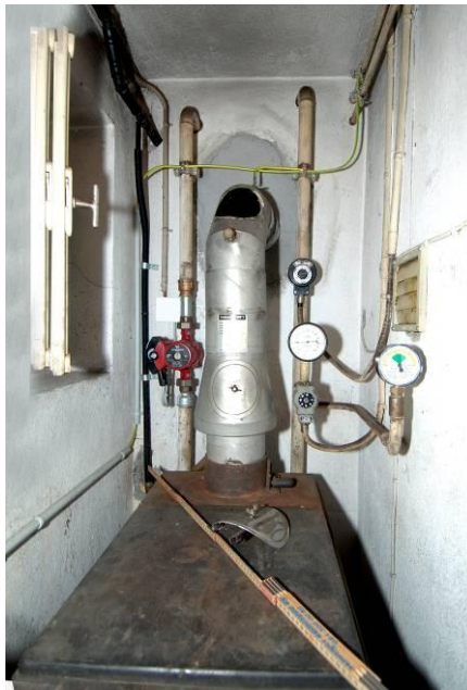
Bildlegende: Das sind die Platzverhältnisse im Heizraum, ein Umbau ist nicht gut möglich: Seitlich je 10 cm, vorne beim Brenner ca. 50 cm. Der sehr warme Heizraum ist für die Hausbesitzerin perfekt geeignet, in der hohen Umgebungstemperatur ihre Pilze dort zu trocknen.
