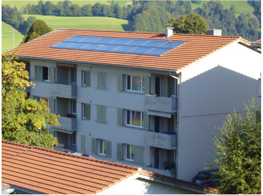
Bildlegende: Auf dem Schrägdach des Mehrfamilienhauses mit neun Wohnungen sind auf einer Fläche von 24 Quadratmetern Sonnenkollektoren angebracht. (Quelle: EV)
