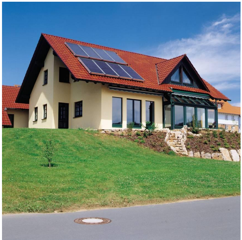
Légende: Les systèmes solaires utilisent l'énergie gratuite du soleil et se combinent sans problèmes avec un chauffage au mazout. (Photo: Viessmann (Suisse) SA)
