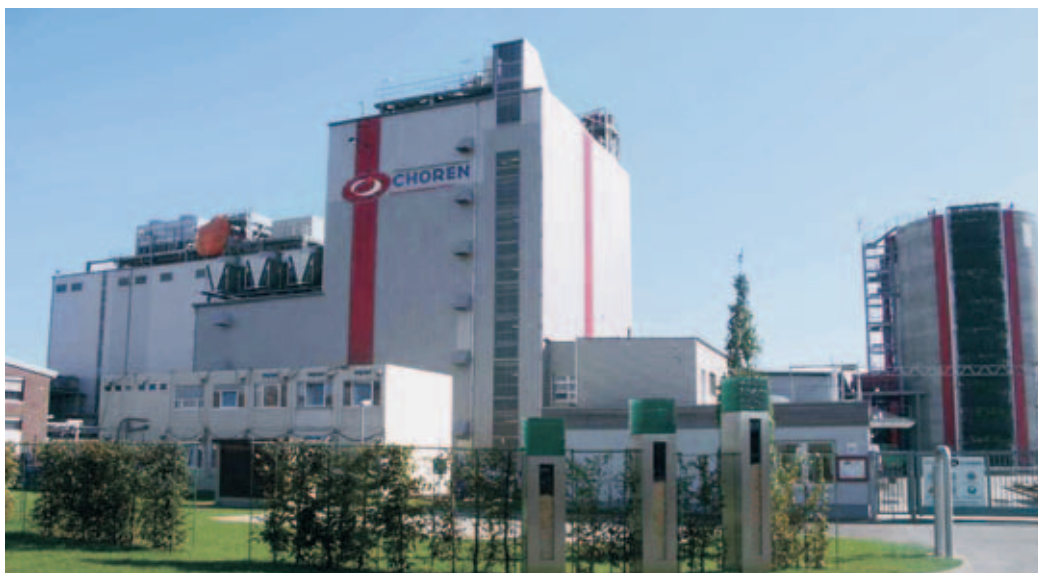
Première installation de production commerciale de BTL. © Choren Industries GmbH (2007)
