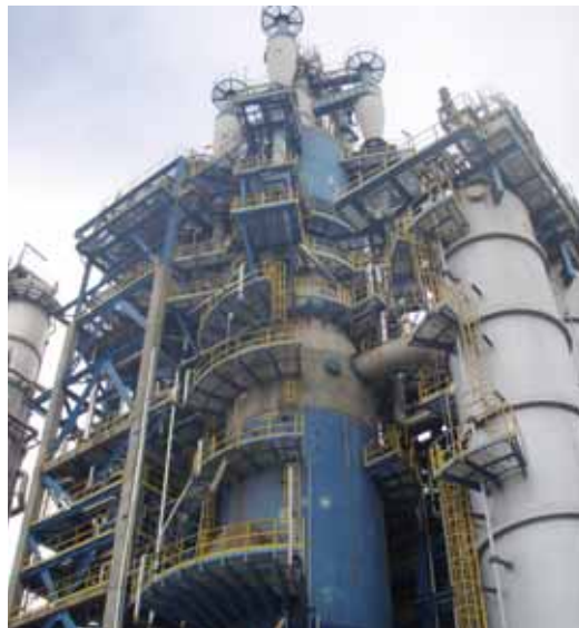
Installation de craquage de la raffinerie de Collombey. Illustration: UP
